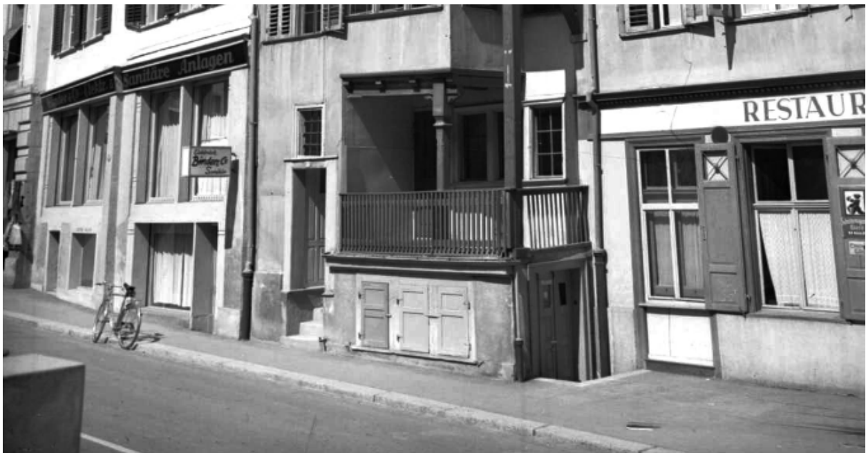
Subordinierter Eingang, Goliathgasse 21, 9000 St. Gallen (1950)
